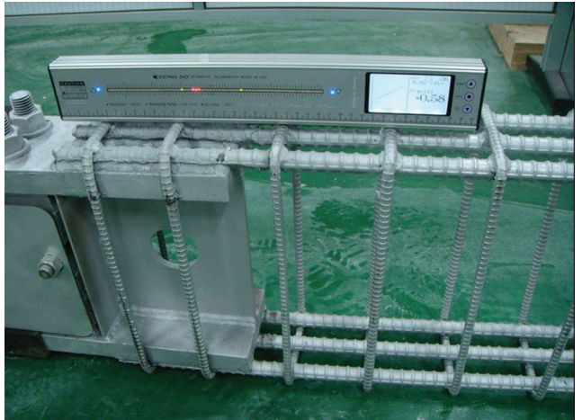
④ 설치 후 수평체크
