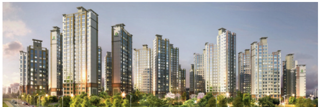
김포 한강신도시 공동주택
