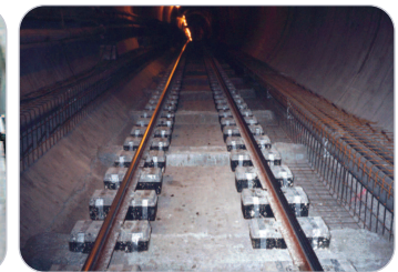
현장에 시공된 모습 2
