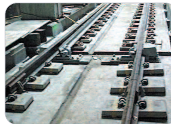
현장에 시공된 모습 1
